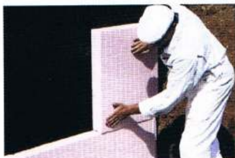
PERI-TOP - die Perimeterdämmung, für Bodenplatte und Kelleraußenwand
